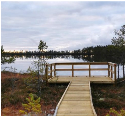
Kuva. Esimerkki puurakenteisesta katselulavasta, jossa alaplena.
