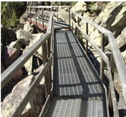
Kuva. Esimerkki teräsrakenteisista pitkospuista, jossa puukaide molemminpuolin.
