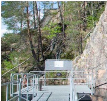
Kuva. Esimerkki teräskenteisistä katselulavasta, jossa teräskaiteet.
