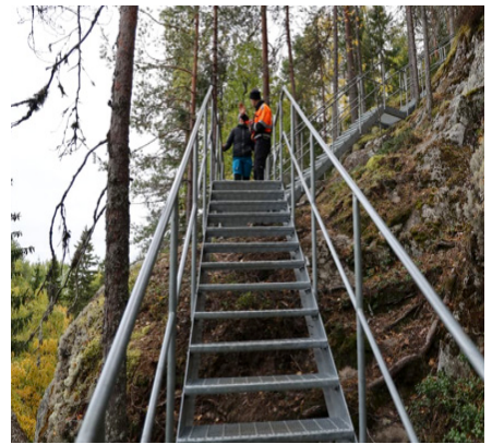
Kuva. Esimerkki teräsrakenteisista portaista, jossa kaide molemminpuolin.
